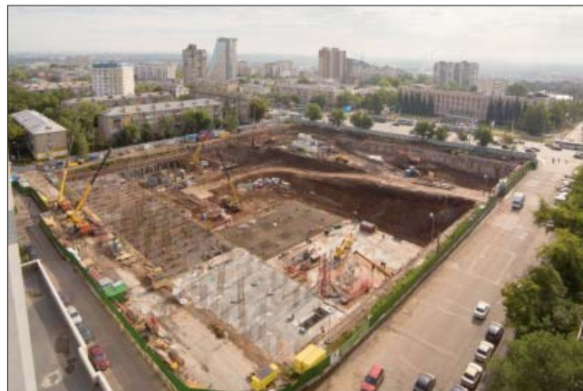
Рис. 3. Общий вид подземной части комплекса
