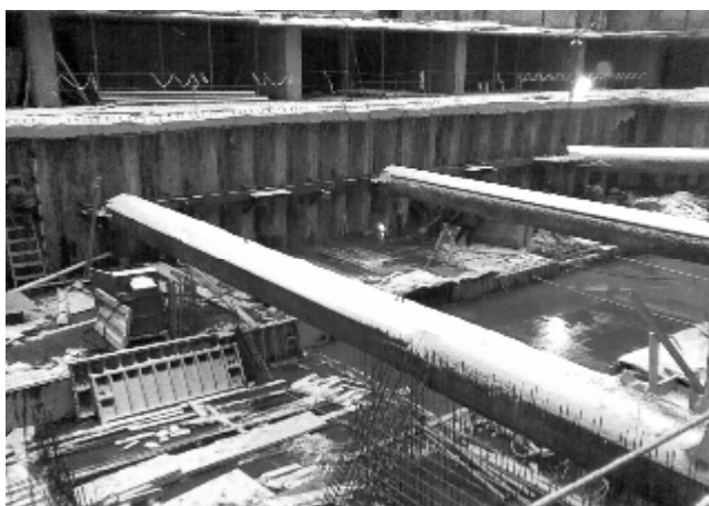
Фото 2. Вскрытый котлован «парк-сейфа». Ведение работ по бетонированию.
