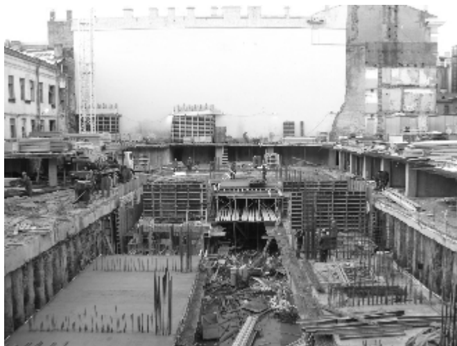
Фото 3. Общий вид котлована «парк-сейфа».
