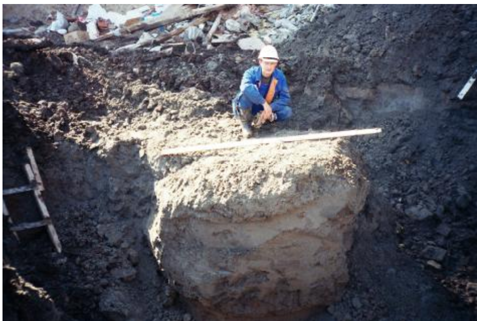
Фото 3. Монолит закрепленного грунта (грунтобетон).
