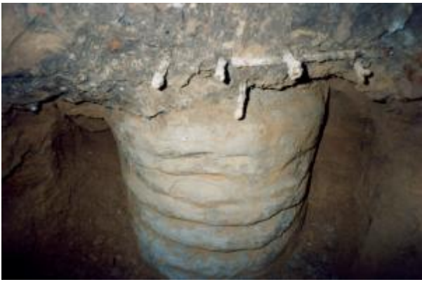
Фото 2. Грунтобетонная свая вскрытая шурфом.
