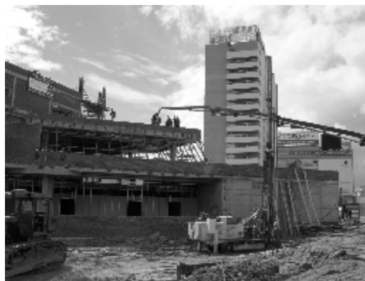
Рис 3. Производство работ на стройплощадке
