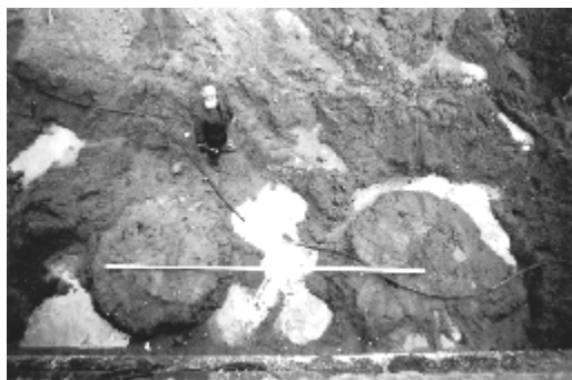
Рис 2. Вид закрепленного грунта.
