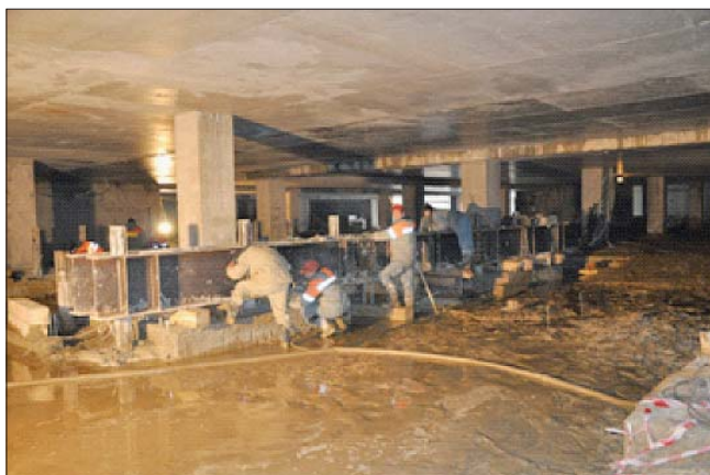
Рис. 8. Монтаж нагружающей системы
