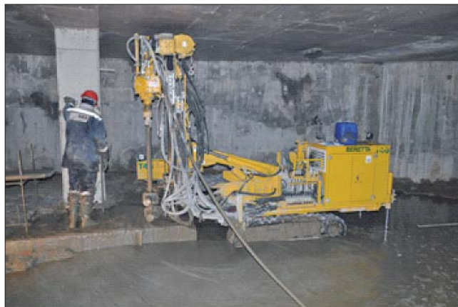
Рис. 5. Выполнение грунтобетонной сваи
