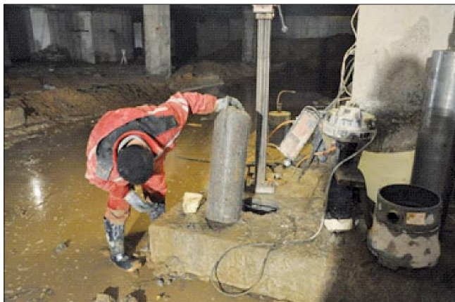
Рис. 4. Проходка технологического отверстия
